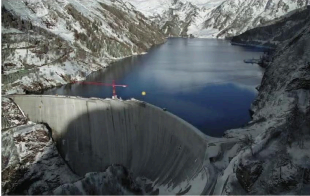
Rehaussement du barrage de 208 m à 225 m Luzzone (TI) 1995 - 1999
